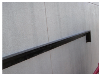
ツルパワーガード本体の取付け
